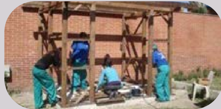
Construcción del cobertizo para las herramientas
