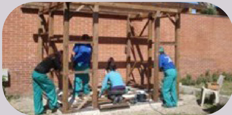
Construcción del cobertizo para las herramientas
