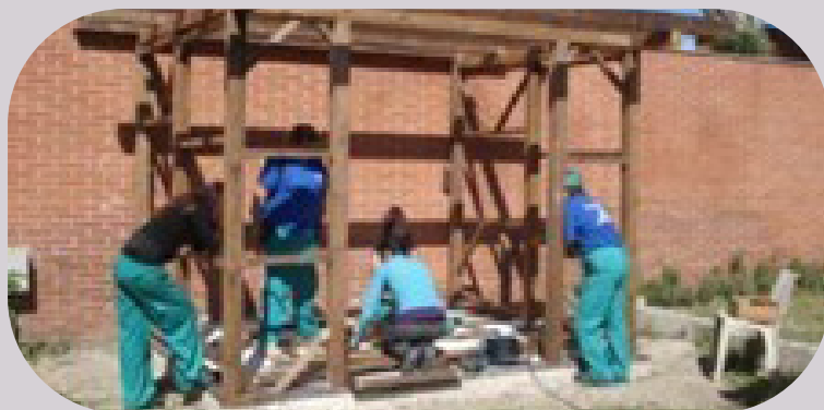
Construction de l'abri à outils
