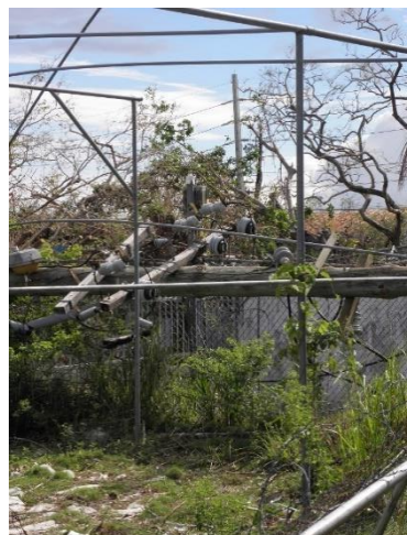
El poste de alto voltaje
